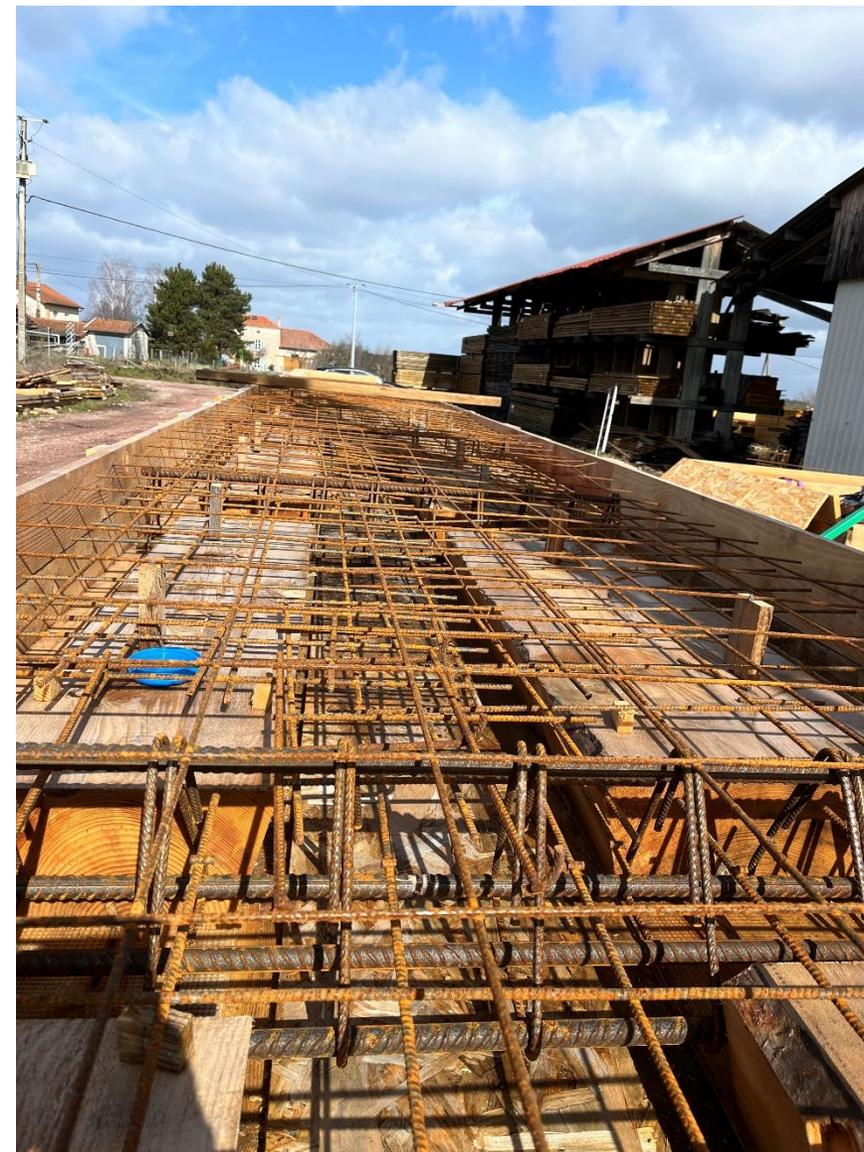
Treillis supérieur et vis de frettage avant coulage sur les Petits Prototypes
