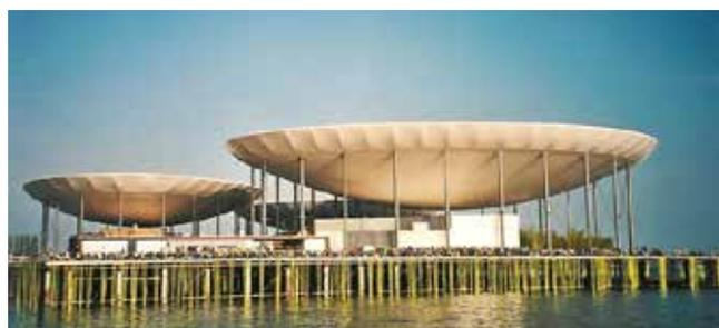
Arteplage : plateformes temporaires conçues par CBS/CBT pour recevoir les bâtiments thématiques. Ces plateformes étant réalisées avant la définition des bâtiments, elles devaient recevoir les surcharges d'exploitation liées au poids du bâti des pavillons et de leur mise en œuvre.
