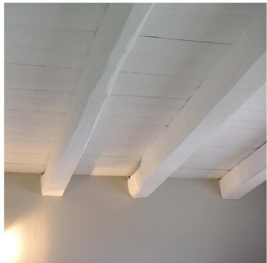
Intervention sur solivage de 140*180 entraxe 800mm
