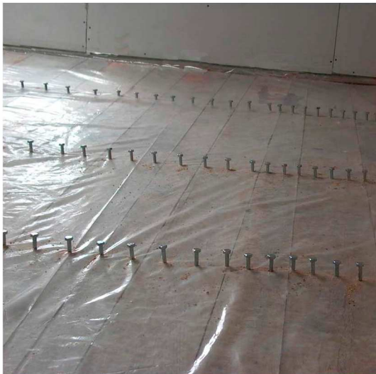
Pose des connecteurs entre bois et béton
