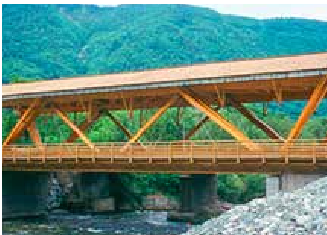
Pont routier sur la Drome à Crest (26) et Pont des Fayettees à Valbonnais (38) (Arborescence)
