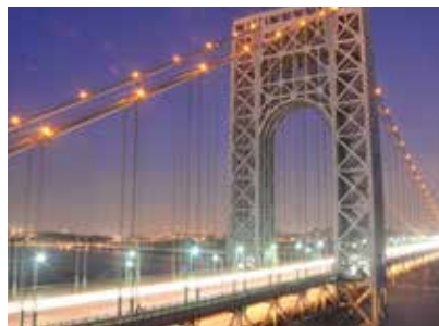
Pont Georges Washington à New York avec 14 voies de circulation
