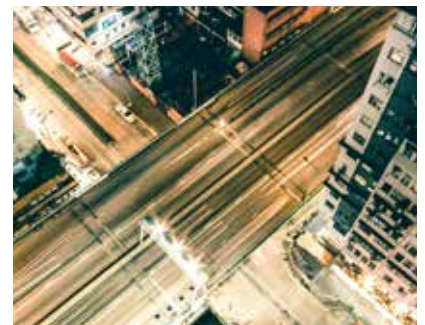
Voirie surélevée à Hong-Kong
