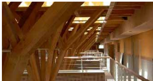
Lycée de Villarbonnot (38)
