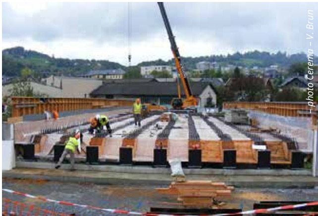
Pont mixte bois béton de Cognin (73160)
