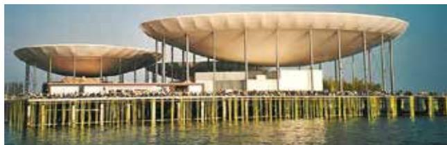
*Arteplage : plateformes temporaires conçues pour recevoir les bâtiments thématiques. Ces plateformes étant réalisées avant la définition des bâtiments, elles devaient recevoir les surcharges d'exploitation liées au poids du bâti des pavillons et de leur mise en oeuvre.*
