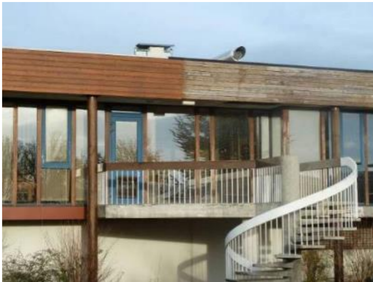
Architecte : Roland Schweitzer
