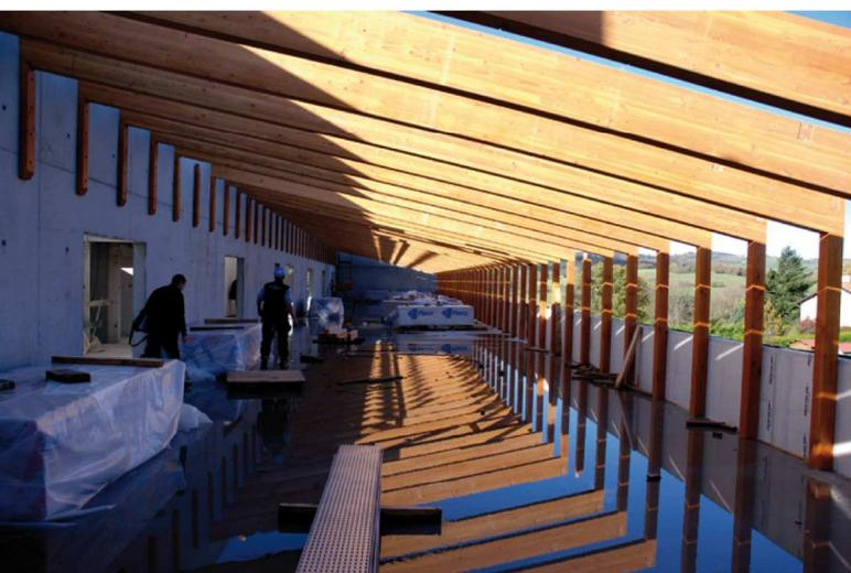
Les salles enterrées reçoivent en partie supérieure la cour de récréation, ce qui permet de réduire les surfaces de toitures, donc les surfaces imperméabilisées et de limiter la taille du bassin de rétention (situé sous le parvis principal et le parking).
