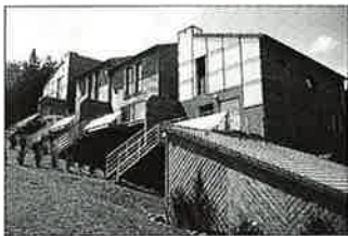
4 Logements groupés à ST Jean Soleymieux (France - 42) Trophée FIBRA 1988 et Trophée National "Le Bois Avance" Trophée "Maisons Solaires d'Aujourd'hui" en Rhône Alpes Maître d'Ouvrage : OPDHLM de la Loire Dominique MOLARD Architecte
