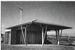
Abri à sel pour DDE de Boen (France - 42) Maître d'Ouvrage : Conseil Général de la Loire Dominique MOLARD Architecte Wolfgang WINTER Ingénieur
